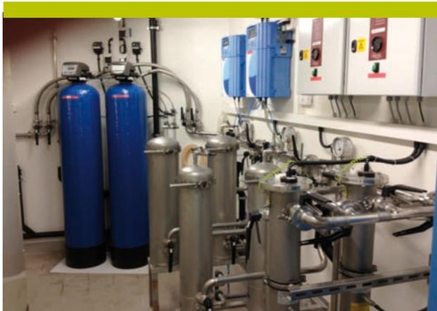
**Figure 1.** Illustration d'un système de traitement de l'eau de dialyse montant les adoucisseurs et l'osmose inverse
